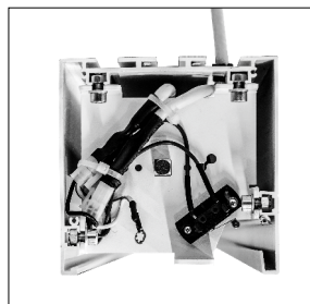
Elektroinstalace včetně dodatečného mikrosplínače
